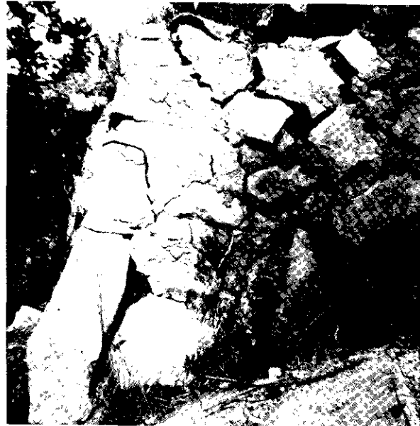
Foto 1.-Ribazo abombado y fracturado pese a su construcción reciente y más sólido, con el empleo de cemento. Muestra de la efectividad y constancia del fenómeno.
