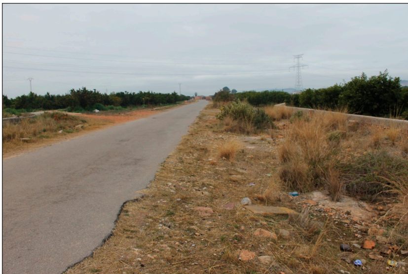
Figura 4. Fotografia del camí de la Ratlla Castelló-Almassora, a la dreta l'antic paleobarranc
