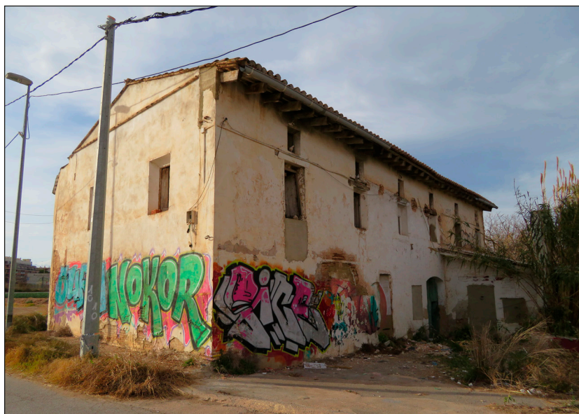
Figura 7. Fachada meridional (izquierda) y oriental (derecha) del Molí de la Sal (fotografía tomada el 8 de marzo de 2023)
