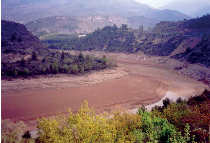
Figura 2. Sedimentos en el embalse de Camarasa, Noguera Pallaresa, Pirineo Central. Presa construida en 1920 (Foto: Ramon J. Batalla)
