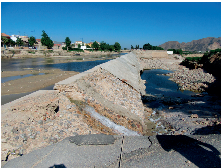
Figura 5. El Paredón en el año 2020, meses después de la crecida de septiembre de 2019. Se puede apreciar la diferencia entre el nivel del cauce aguas arriba y la base de la presa, fruto de la retención histórica de sedimentos
