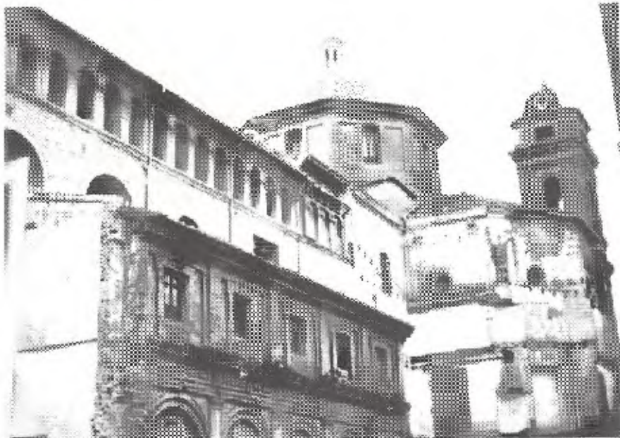
8. Vestigios actuales de la vieja Casa Profesa, vistos desde la calle de la Purísima. En primer término, lienzo meridional subsistente del claustro mayor, y cuerpo exterior de la vieja librería. Al fondo, la iglesia decimonónica
