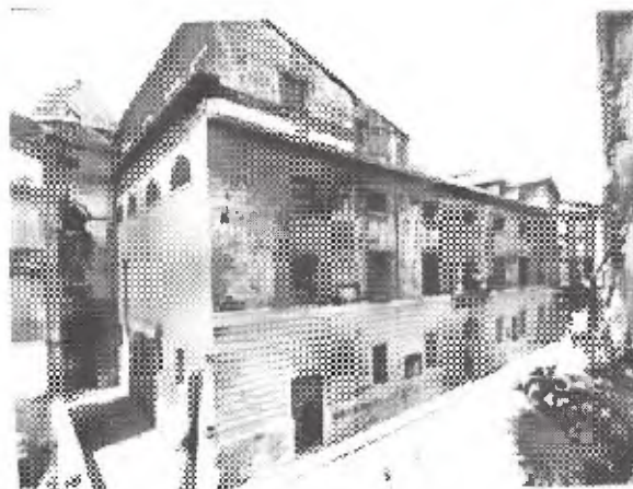
10. Cuerpo exterior de la vieja Casa Profesa, desde la calle de la Purísima (foto Desfilis, publicada en julio de 1936, por Valencia-Atracción , momento de su parcial derribo)
