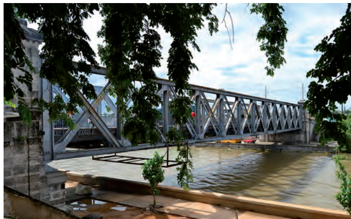
Fig. 7. Puente Calixto García (1897), en el emplazamiento que ocupaba el antiguo de Bailén. Fotografía del autor.
