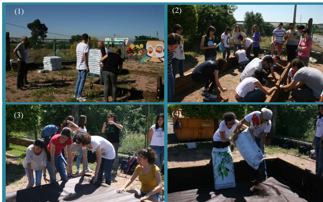
IMAGEN 1. Construcción del huerto no permanente con fines docentes en la Facultad de Ciencias de la Educación en cuatro fases: 1. Elección de la ubicación; 2. Construcción del cajón; 3. Forrado del cajón con tela aislante; 4. Llenado del cajón con mantillo
