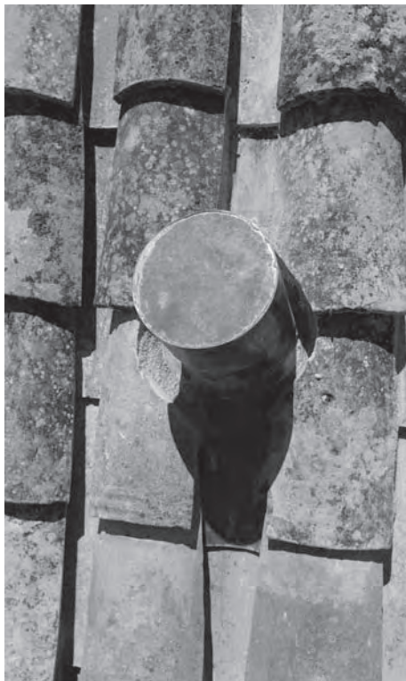
Registro para inspección y manipulación de una de las bajantes ocultas después de la intervención. Cubiertas de la C/ Campanas. Catedral de Jaén.
