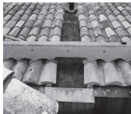
Pasillo de mantenimiento, esquema de evacuación de aguas pluviales y fotografía de estado tras la actuación. Cubierta C/ Campanas. Catedral de Jaén.
