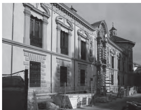
Bajantes de cobre adosadas a la fachada. Palacio de Bibataubín de Granada.
