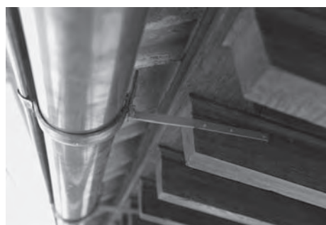
Detalle de canalón de cobre suspendido bajo el alero. Sala de los Reyes en la Alhambra de Granada.
