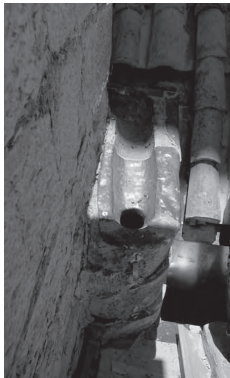
Forrado de plomo de la entrada de una bajante oculta paralela a un contrafuerte. Catedral de Jaén.
