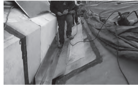
Tela asfáltica de alta durabilidad protegida con chapa de cobre de 1 mm en una canal de las cubiertas laterales de la Catedral de Jaén.
