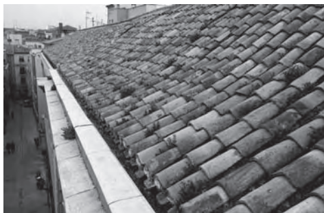
Canal obstruida por vegetación produciendo humedades en fachada. Palacio de las Columnas de Granada.
