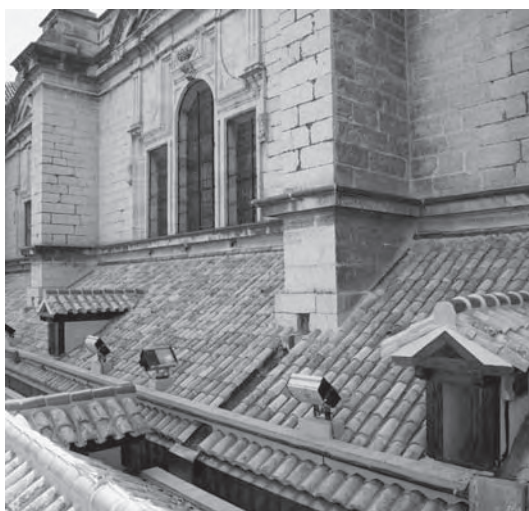
Canal oculta, estado previo y reformado. Se puede observar el espacio liberado para facilitar el mantenimiento. Cubierta C/ Campanas. Catedral de Jaén
