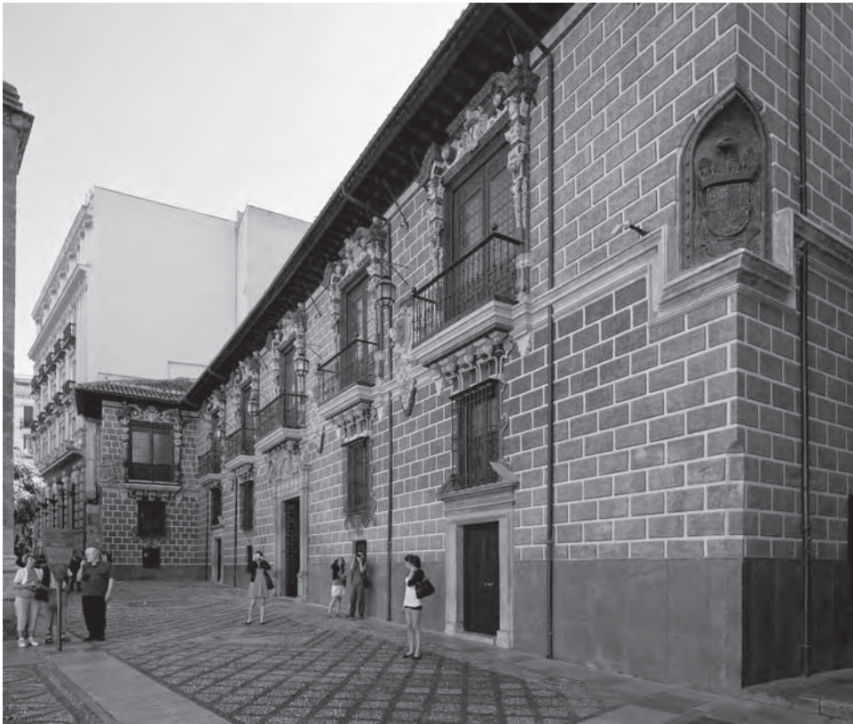
Bajantes exteriores de cobre. El sistema combinado de canales y bajantes evita la caída directa del agua en el plano inferior de fachada. Palacio de la Madraza, Granada. FOTOGRAFÍA: Fernando Alda.
