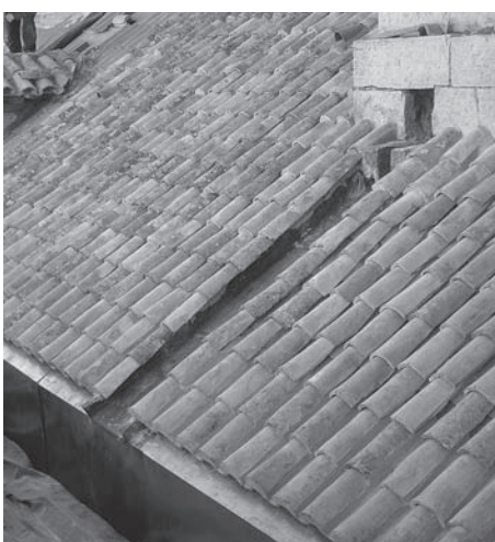
Encuentro entre bajante oculta y canal de evacuación de aguas, antes y durante de la intervención. Catedral de Jaén.
