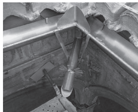
Detalle de gárgola de cinc para evacuación de aguas en los canalones suspendidos bajo las cornisas. Hospital Real de Granada.
