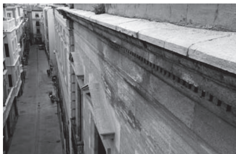
Canal obstruida por vegetación produciendo humedades en fachada. Palacio de las Columnas de Granada.
