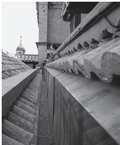
Canal oculta, estado previo y reformado. Se puede observar el espacio liberado para facilitar el mantenimiento. Cubierta C/ Campanas. Catedral de Jaén
