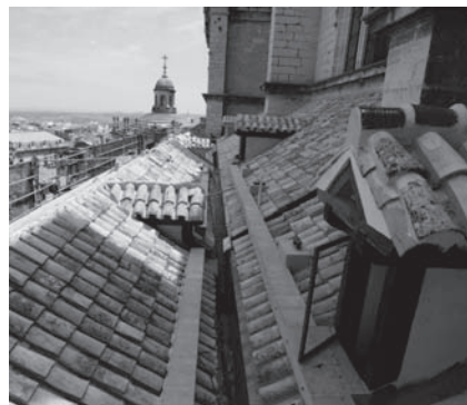
Canal oculta, estado previo y reformado. Las tejas se han retranqueado para facilitar el mantenimiento. Cubierta c/ Campanas. Catedral de Jaén.
