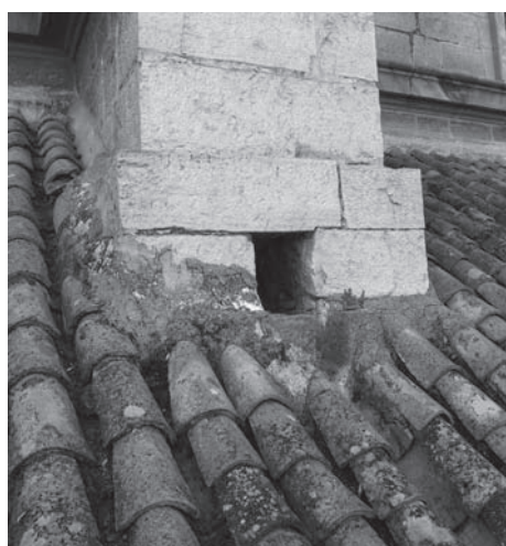
Encuentro entre bajante oculta y canal de evacuación de aguas, antes y durante de la intervención. Catedral de Jaén.
