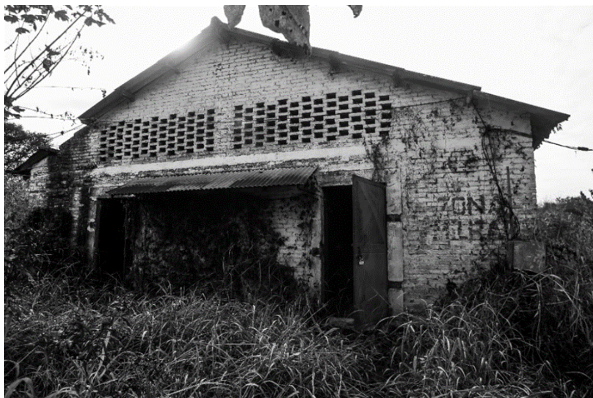
Fotografía 9: entrada al galpón 9. Arsenal Miguel de Azcuénaga. Fotografía de Juan Pablo Sánchez Noli.
