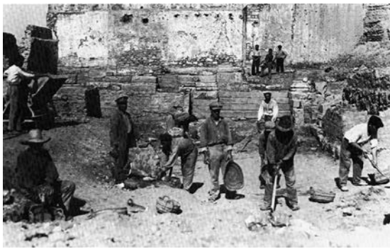
Fig. 15: Vista general desde la plaza del flanco N del foro durante los trabajos arqueológicos de 1932, donde se aprecia a la izquierda de la escalera la situación de una losa vertical (procedencia de la imagen: González Simancas 1933: lám. IV A).
