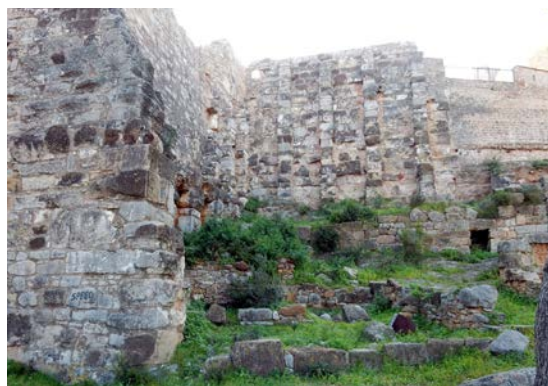
Fig. 12: Muros de aterramiento y salida de la cloaca del foro de Saguntum.
