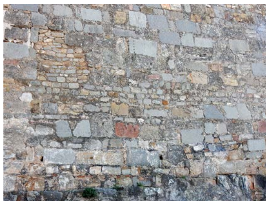
Fig. 9: Lienzo murario en la plaza de San Fernando del castillo de Sagunto. En la parte superior del centro de la imagen se observa una de las losas del pavimento de la plaza del foro augusteo con una línea de orificios.
