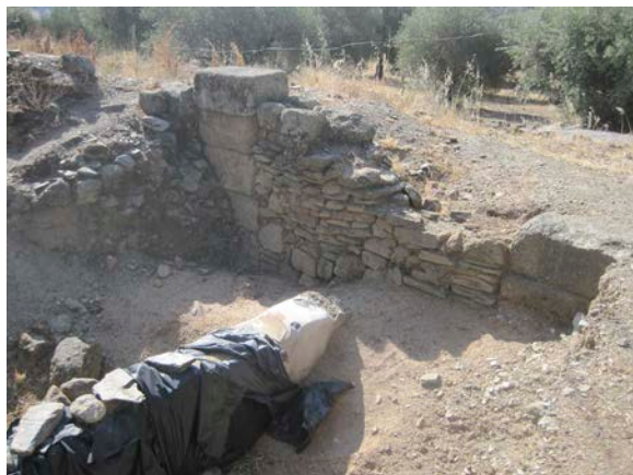
Fig. 5: Pilares del pórtico de la plaza del templo altoimperial y cegamiento con mamposería y pizarra de los intercolumnios (Autora).
