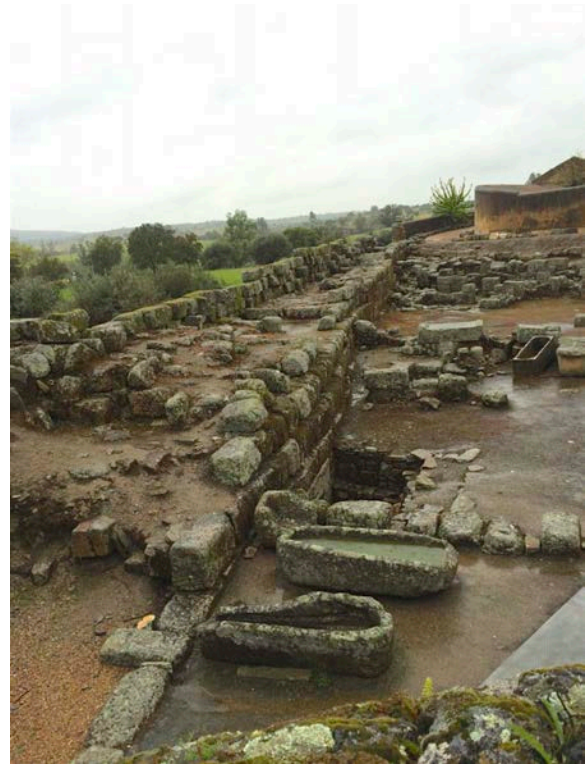
Fig. 13: Muralla tardía de la civitas Igaeditanorum. Sector SO que engloba el Paço dos Bispos donde se observa la deformación del paramento de la muralla a consecuencia de un seísmo (Autora).
