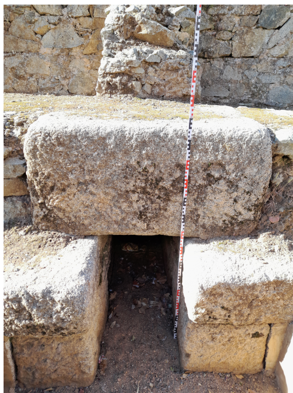
Fig. 20. Canal de evacuación bajo el graderío O del circo de Emerita Augusta (Foto: tomada por el autor).
