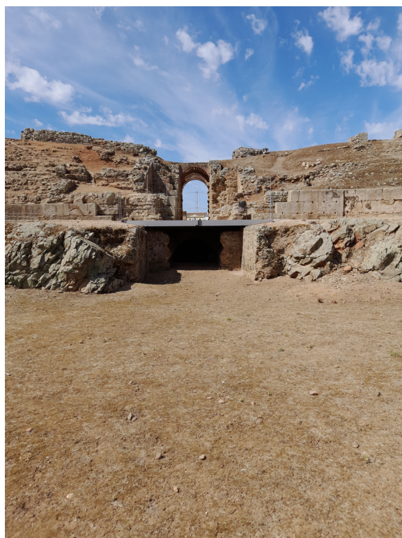
Fig. 14. Canal de evacuación en la fosa bestiaría sobre el eje menor del anfiteatro de Emerita Augusta (Foto: tomada por el autor).
