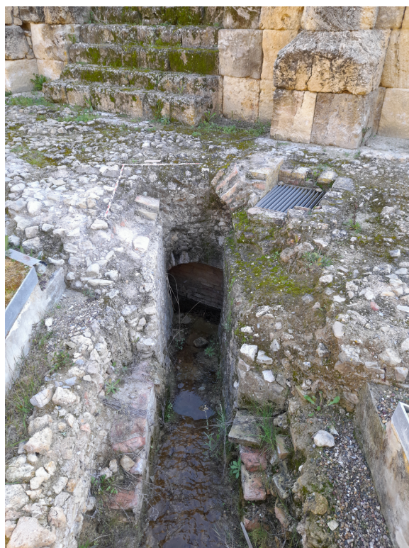
Fig. 16. Cloaca perimetral a su entrada desde el lado O del anfiteatro de Italica (Foto: tomada por el autor).
