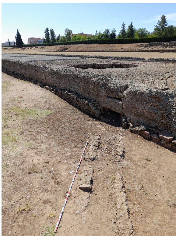
Fig. 19. Euripus en la zona O de la spina del circo de Emerita Augusta (Foto: tomada por el autor).
