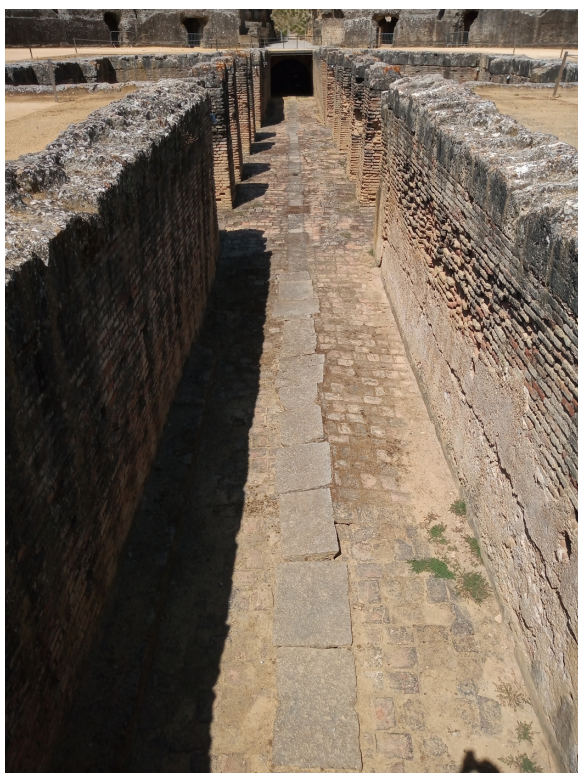
Fig. 17. Cloaca en la fossa bestiaria del anfiteatro de Italica (Foto: tomada por el autor).
