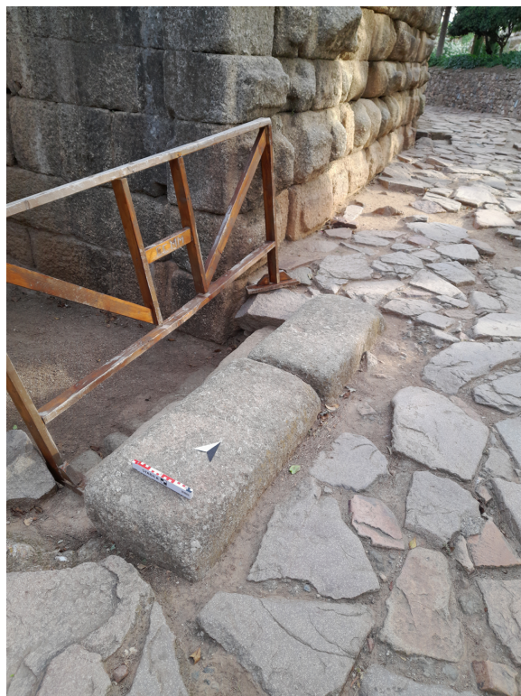
Fig. 6. Peldaños de granito en los umbrales de la fachada del teatro. (Foto: tomada por el autor).
