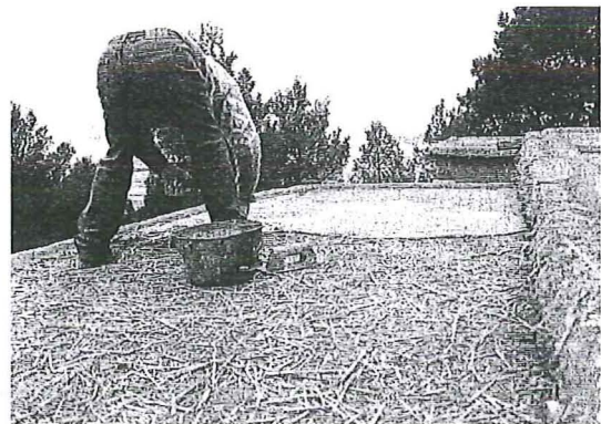
Figura 9. Colocación de la cubierta de tierra.
