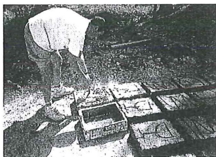
Figura 4. Fabricación de adobes.
