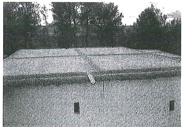
Figura 16. Acabado de la cubierta con los caballones para redistribuir la salida de aguas.
