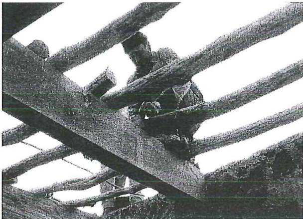
Figura 7. Colocación de coronamiento, vigas y rollizos.
