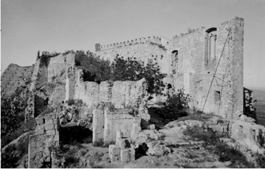
Figura 6. Exterior i accés a les estances del Duc de Calàbria. AHMX, Fons Loty, vers 1920.
