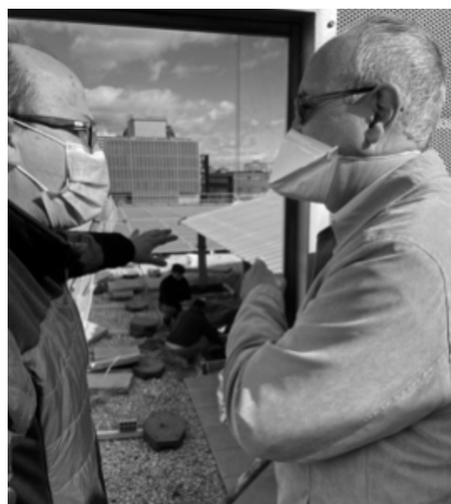
Reparación de filtraciones sobre la Palmireno
