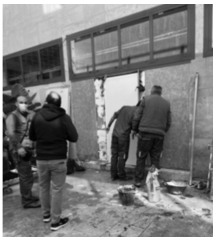
Substitución de una puerta de acceso lateral
