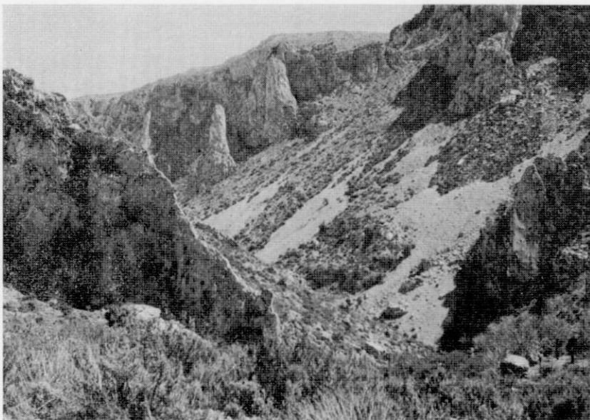
Foto 3.—Barranc de Malafí. Cantiles y taludes en el margen derecho, con frases y entrantes del cantil. Las bandas de vegetación al pie de la pared rocosa atestiguan la escasa alimentación (exceptuando caídas de algunos bloques). Puede apreciarse, a mitad del talud, un afloramiento de la roca madre, presumiblemente del núcleo rocoso subyacente.
