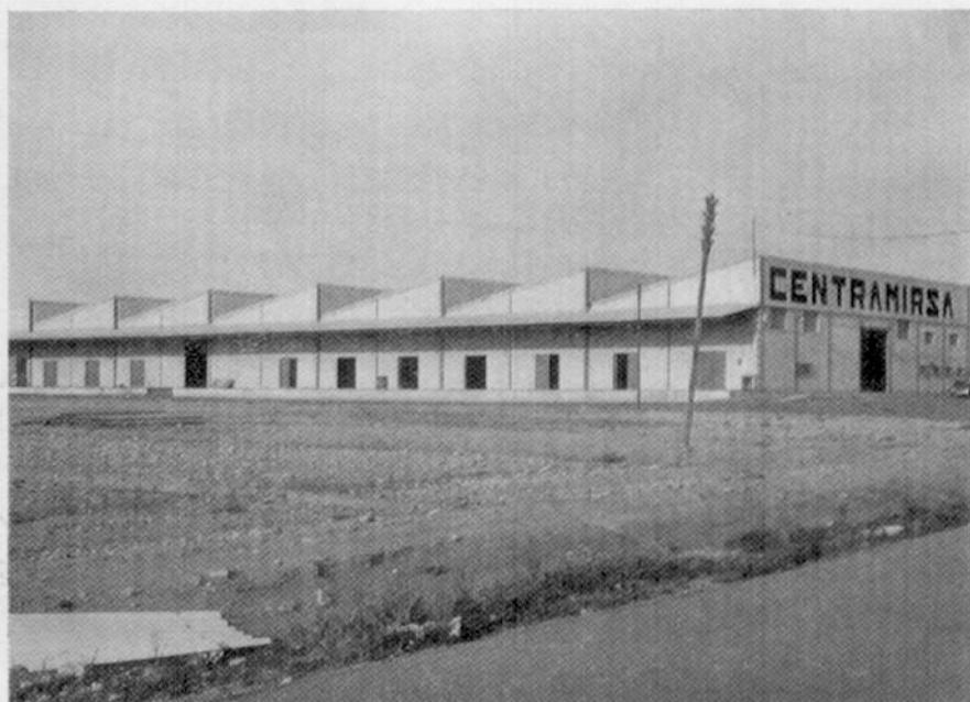
Foto 4.—Alhóndiga o corrida de El Mirador, gran almacén donde se subastan productos hortícolas de la zona, erigido en 1977 al calor del incremento de las cosechas de invernadero.
