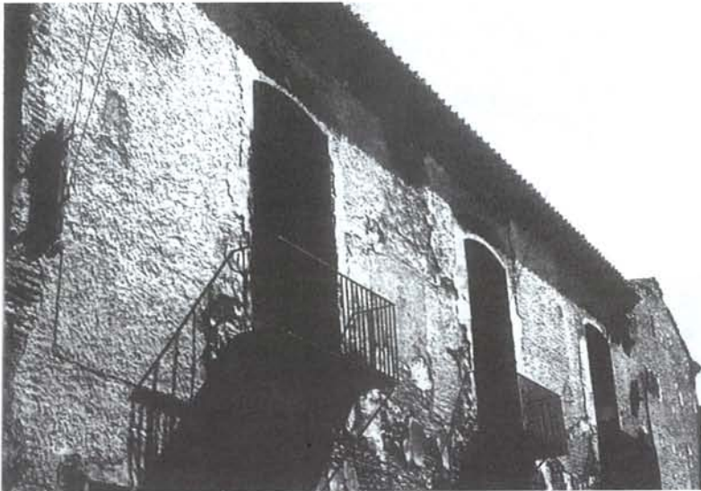
• FIGURA VIII. Casa de la Señoría (Olocau). Detalle de los balcones en el piso principal. Foto: Castillos, torres y fortalezas de la Comunidad Valenciana (1995), Editorial Prensa Valenciana, p. 351.
