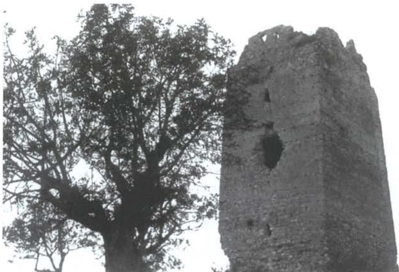
• FIGURA XXIII. Torre del Castillo de Montroy. Reproducción facilitada por cortesía de don José M a Camí Orrit, secretario del Ayuntamiento de Montroy.
