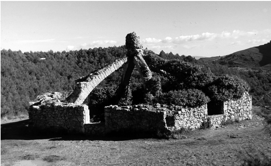
8. La Cava Gran (Agres) en la sierra de Mariola. En 2005 se eliminó la hiedra que cubría peligrosamente gran parte del pozo y de los arcos.
