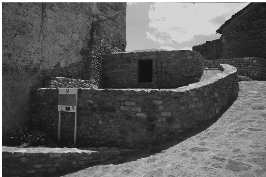
2. La nevera del Forcall en 1997 tras los trabajos de rehabilitación con fondos del programa europeo LIFE.
